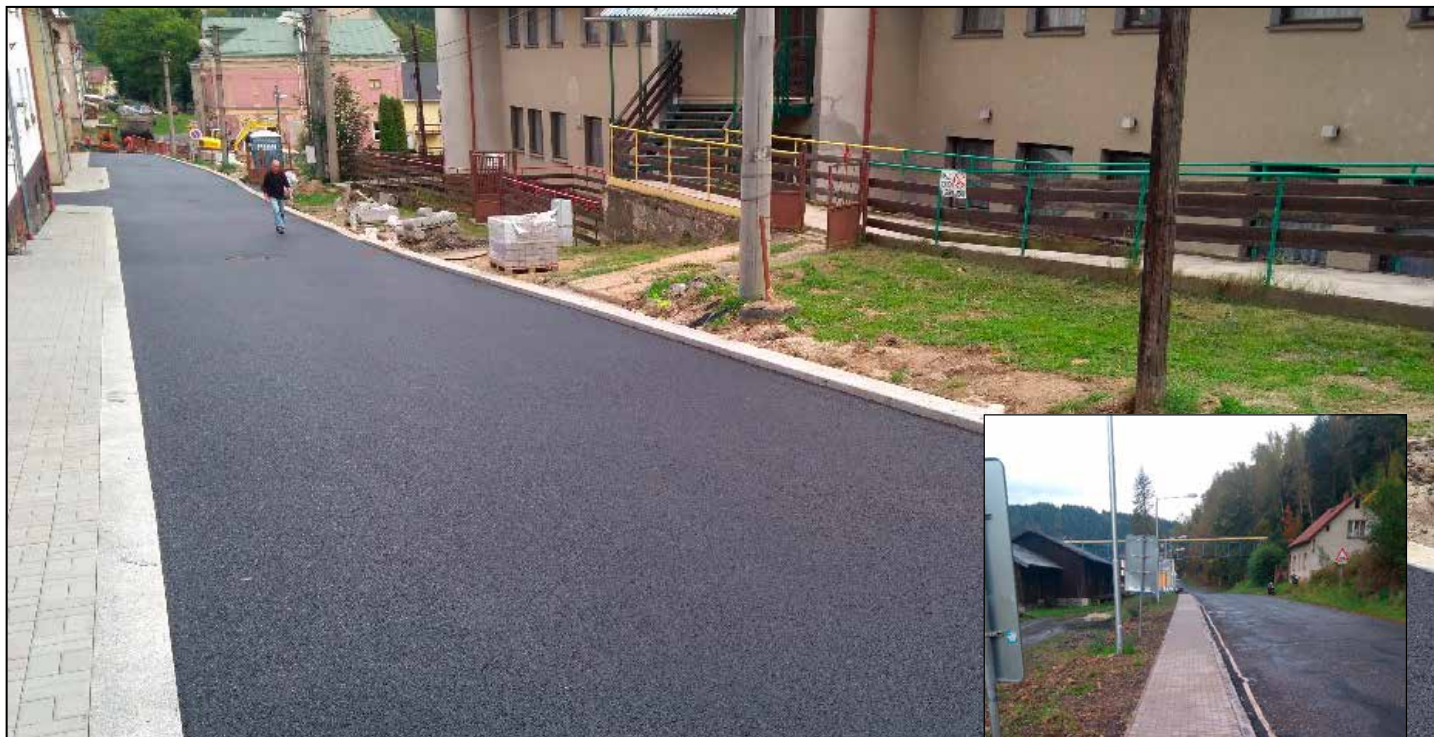
Zrekonstruovaná Radniční ulice.
